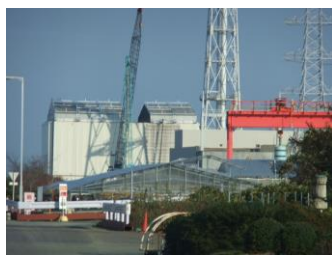
1号機原子炉建屋屋根
